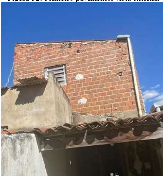
Figura 32: Primeiro pavimento, vista externa.
