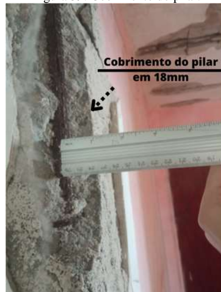
Figura 39: Cobrimento do pilar.
