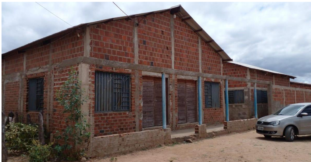
Figura 8 - Fachada do prédio de extensão da Escola Estadual São Francisco
