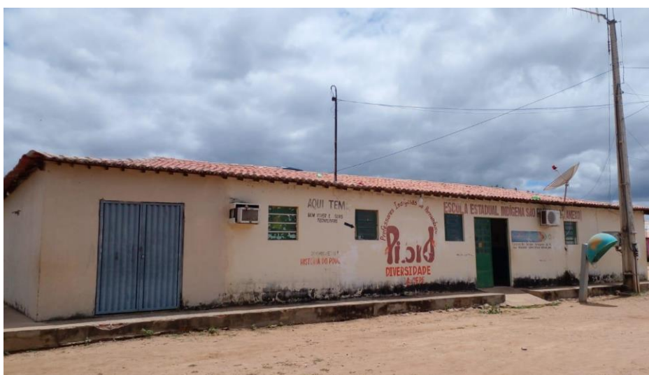
Figura 7 - Fachada da sede provisória da Escola Estadual São Francisco
