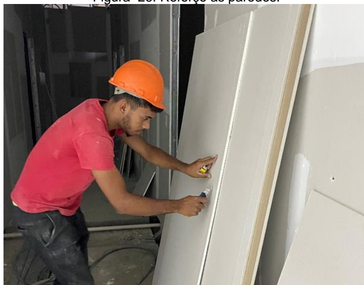
Figura 26: Reforço as paredes.
