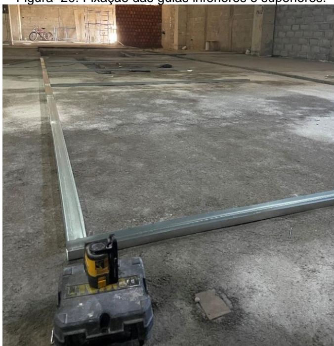
Figura 20: Fixação das guias inferiores e superiores.
