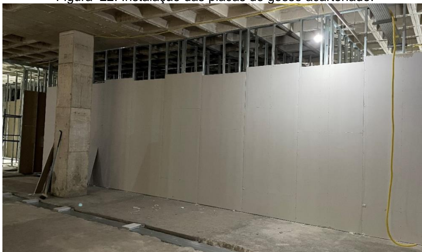
Figura 22: Instalação das placas de gesso acartonado.
