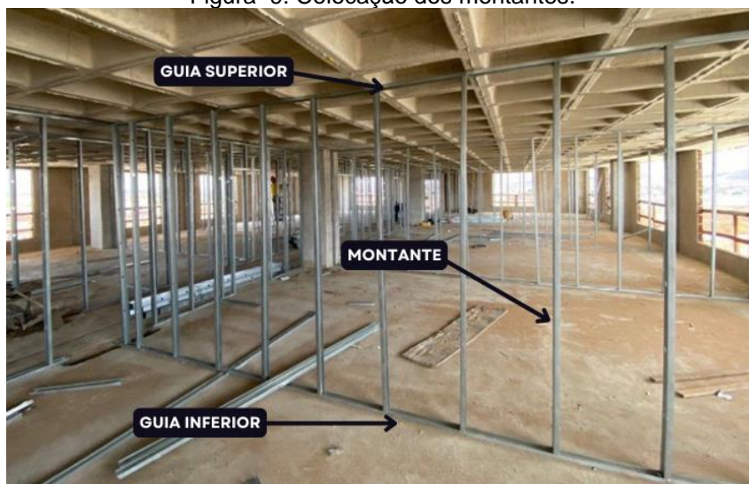
Figura 9: Colocação dos montantes.
