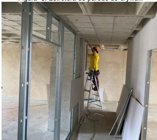
Figura 5: Estrutura de parede de drywall .
