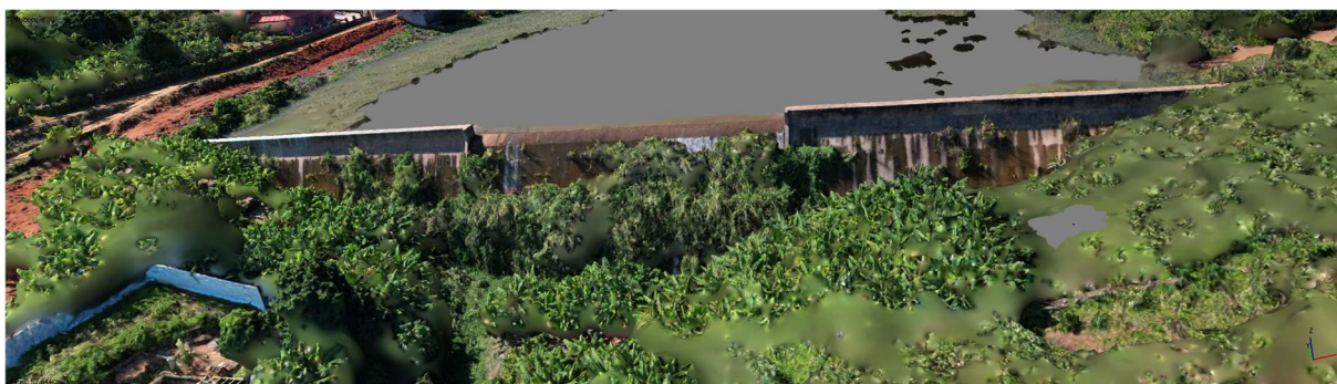
Figura 49 - Vista geral da região a jusante
