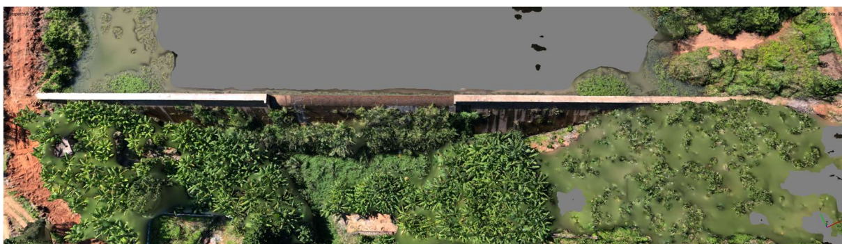
Figura 47 - Vista geral do paramento de jusante - Mapeamento 29/06/24
