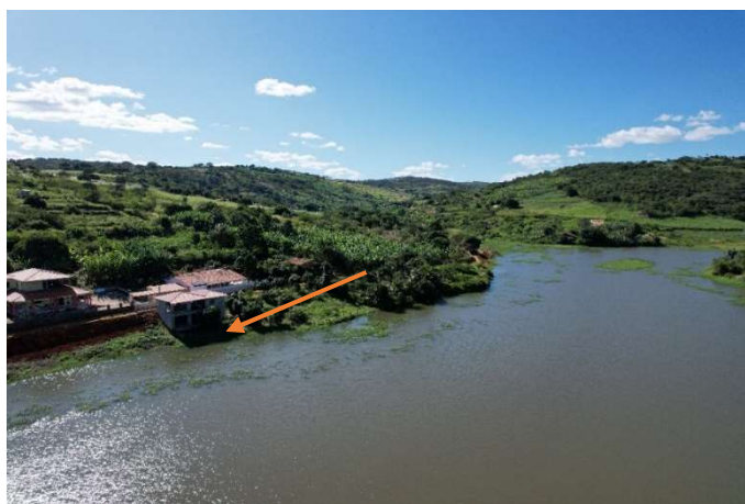
Figura 37 – Reservatório – Foto obtida com drone
