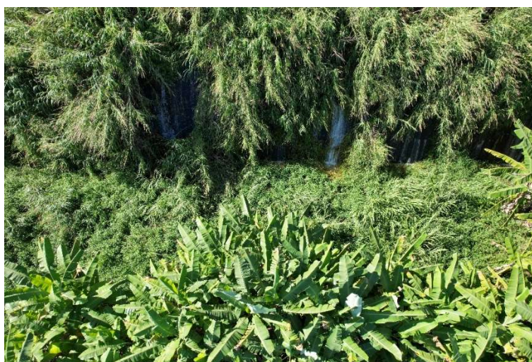
Figura 38 - Densa vegetação região a jusante da barragem – Foto registrada com drone
