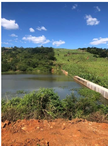
Figura 24 - Vista geral do coroamento na inspeção 3
