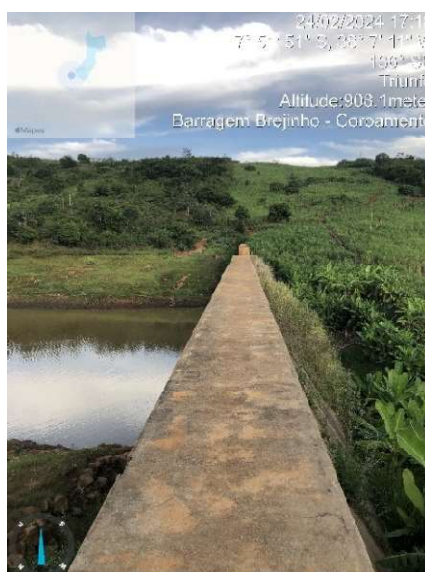
Figura 21 - Vista do coroamento da barragem observada da lateral esquerda na inspeção 2
