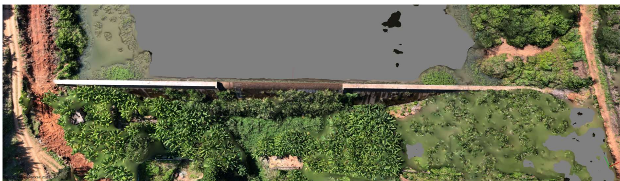
Figura 45 - Vista geral da crista da barragem - mapeamento 29/06/24
