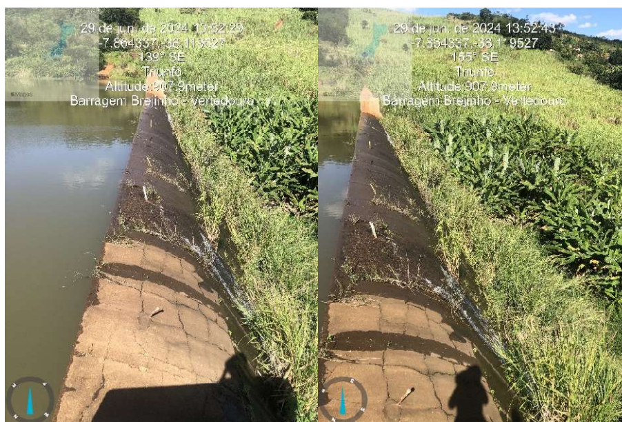
Figura 34 - Condições do sangradouro - Visita 03
