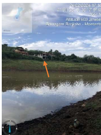
Figura 36 - Novas construções dentro da área de preservação permanente da barragem
