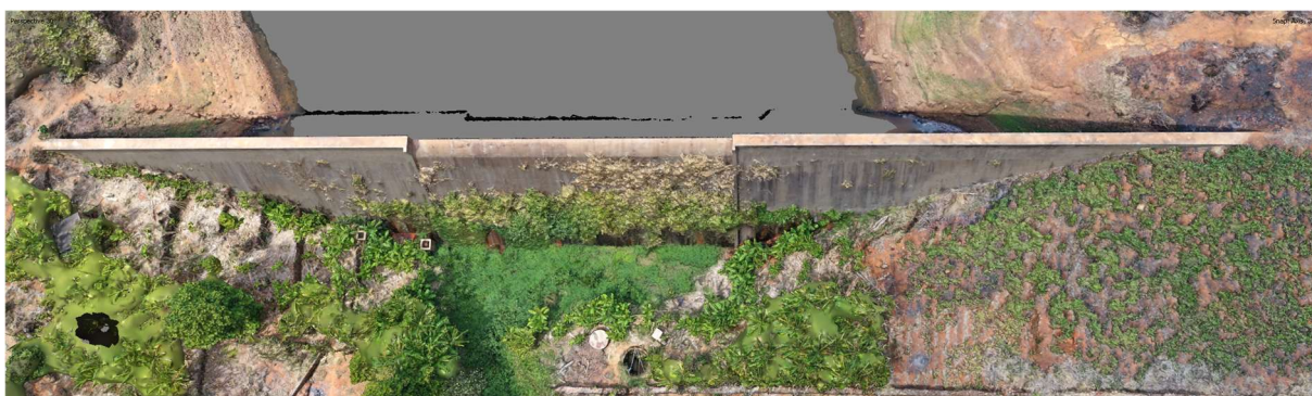
Figura 46 - Vista geral do paramento de jusante - Mapeamento 09/12/23
