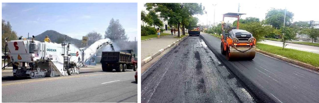
Figura 13: Técnica de fresagem à esquerda e recapeamento à direita
