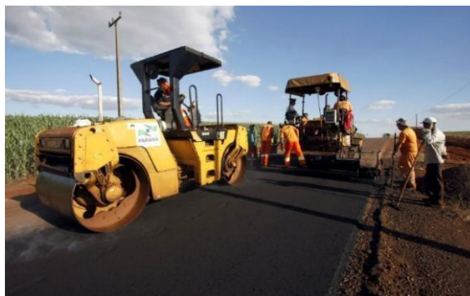
Figura 12: Técnica de micro revestimento no Noroeste do Paraná
