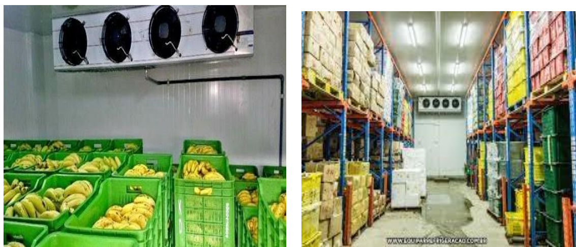
Figura 6 – Uso de câmaras frias para armazenamento refrigerado com grande volume de frutos. Fonte: Google Imagens.
