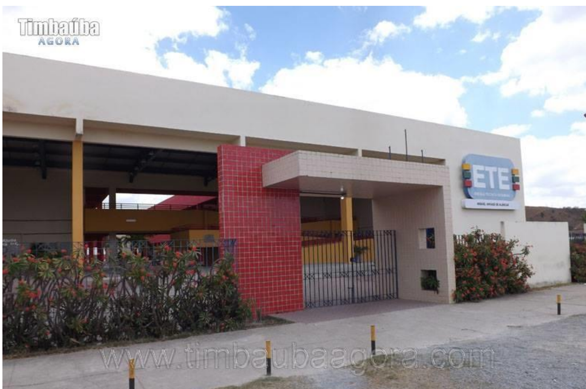
Foto da entrada da ETE Pedro Muniz Falcão, Araripina-PE. Fonte: Timbaúba Agora
