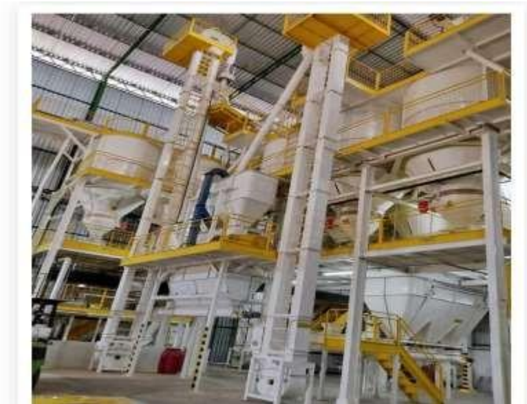
Figura 2 – Silos de Armazenagem
