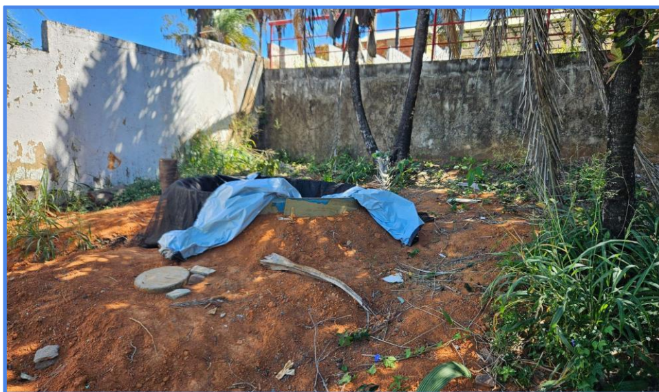
Figuras 9: Caixa d’água submersa
