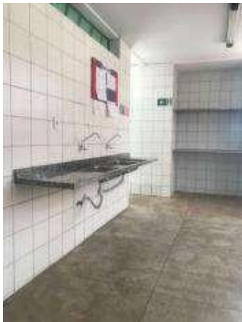
Figura 4 - Registro após a limpeza da área de produção
