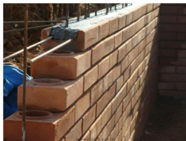
Figura 5: Detalhe de uma fiada de tijolo canaleta
