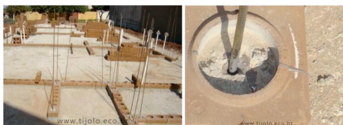
Figura 3: Primeira fiada de tijolos com fixação dos ferros
