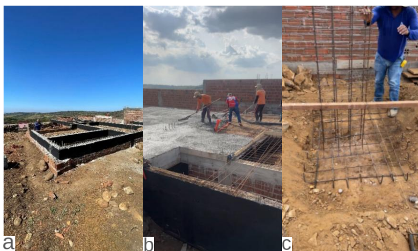
Figura 25: Baldrame Impermeabilizadas (a), Concretagem da laje maciça (b), Armação da Sapata (c)
