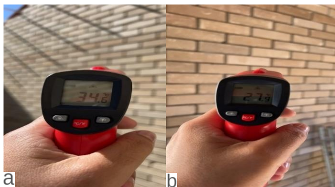
Figura 7: Temperatura do lado externo da alvenaria (a), temperatura do lado interno da alvenaria (b)
