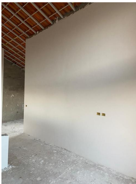
Figura 34: Alvenaria com aplicação de gesso e alvenaria no emboço para aplicação do revestimento
