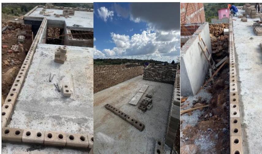
Figura 27: Primeira fiada de tijolos com argamassa
