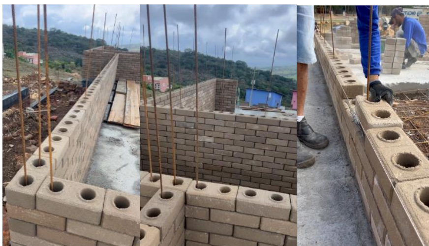
Figura 28: Fixação dos ferros na alvenaria
