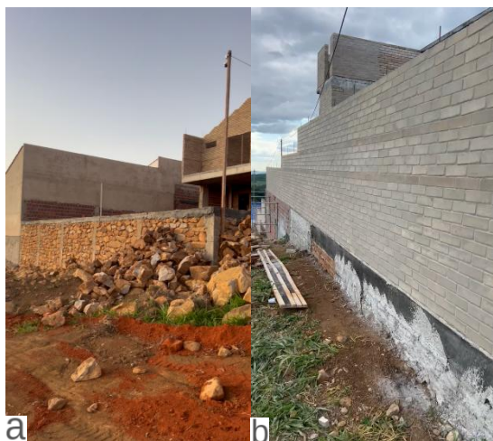
Figura 31: Muro de arrimo (a), muro com tijolo ecológico e embasamento em blocos cerâmicos (b)
