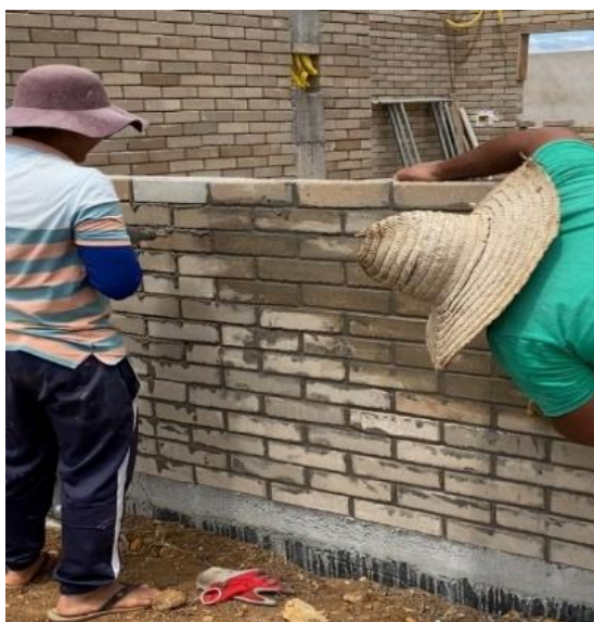
Figura 30: Aplicação do rejunte na alvenaria
