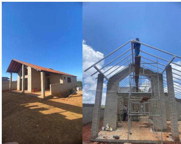
Figura 32: Cobertura em telha cerâmica e trama metálica
