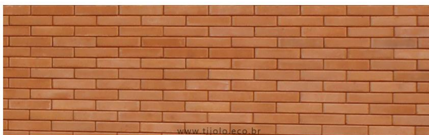
Figura 6: Alvenaria com acabamento do rejunte flexível
