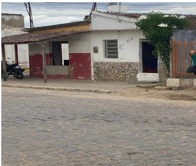
Figura 12 – Construção de fiadas de alvenaria com o objetivo de conter a água.
