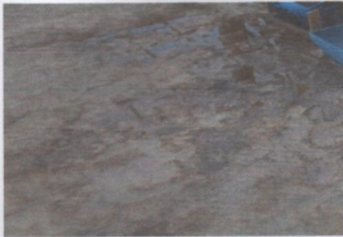
**Ilustração 24:** Piso formado por paralelepípedo. Observa-se que o mesmo retém a água que devia ter escorrido.
