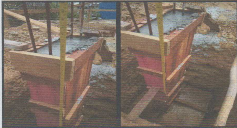
Figura 2 - Concretagem de pilares
