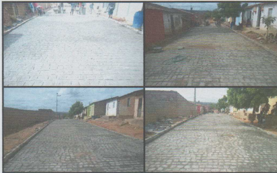
Figura 5 - Assentamento do pavimento e aplicação de gorda de cimento
