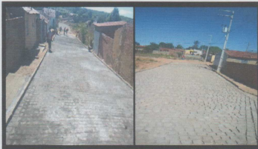
Figura 6 - Assentamento dos paralelos e obra finalizada
