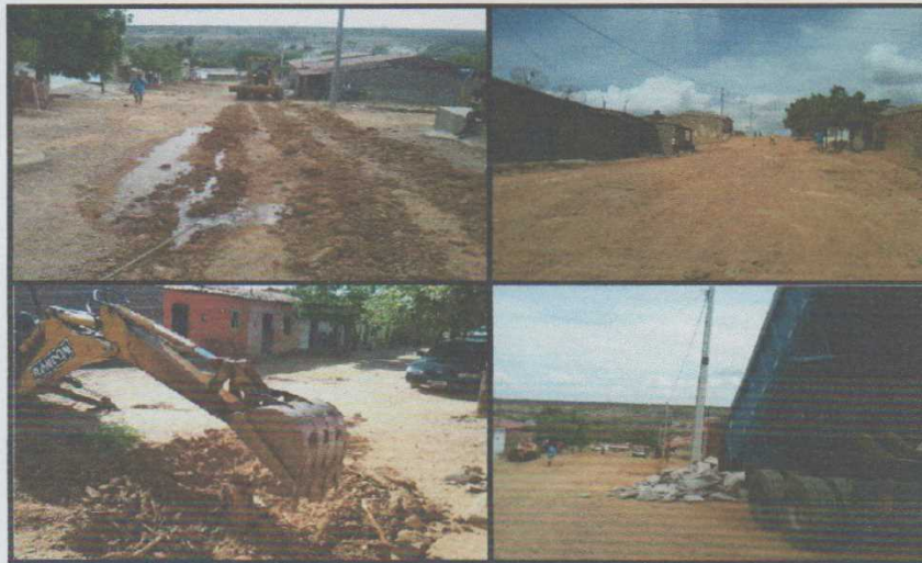
Figura 7 - Serviço de terraplenagem, retirada de árvore e recebimentos de materiais
