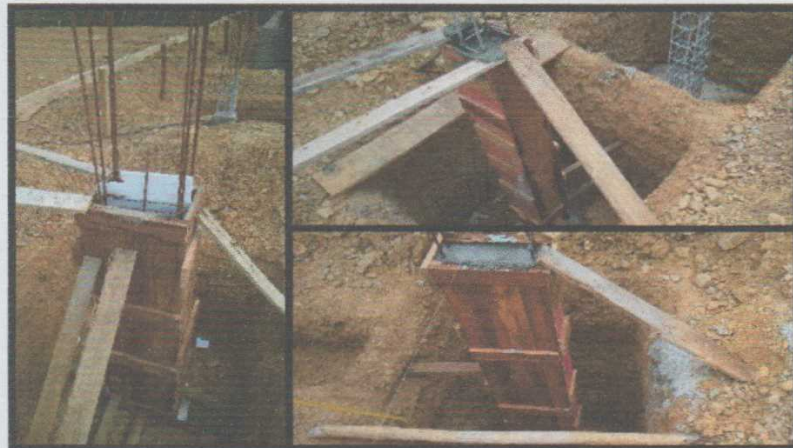
Figura 3 - Montagem de Fôrmas e lançamento de concreto
