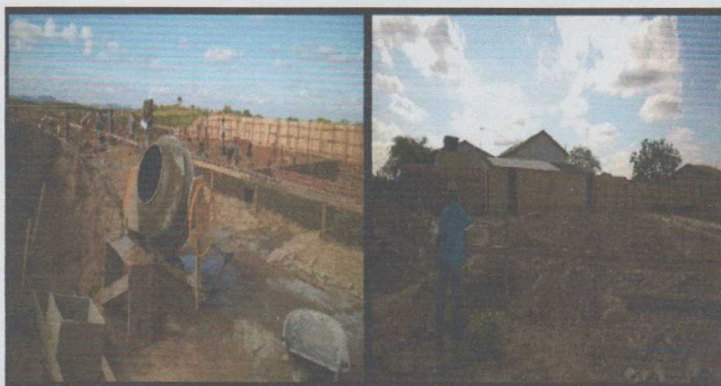
Figura 1 - Construção do canteiro de obras e execução da fundação
