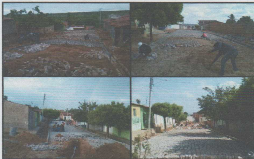
Figura 8 - Aplicação de colchão de areia e assentamento dos paralelepípedos
