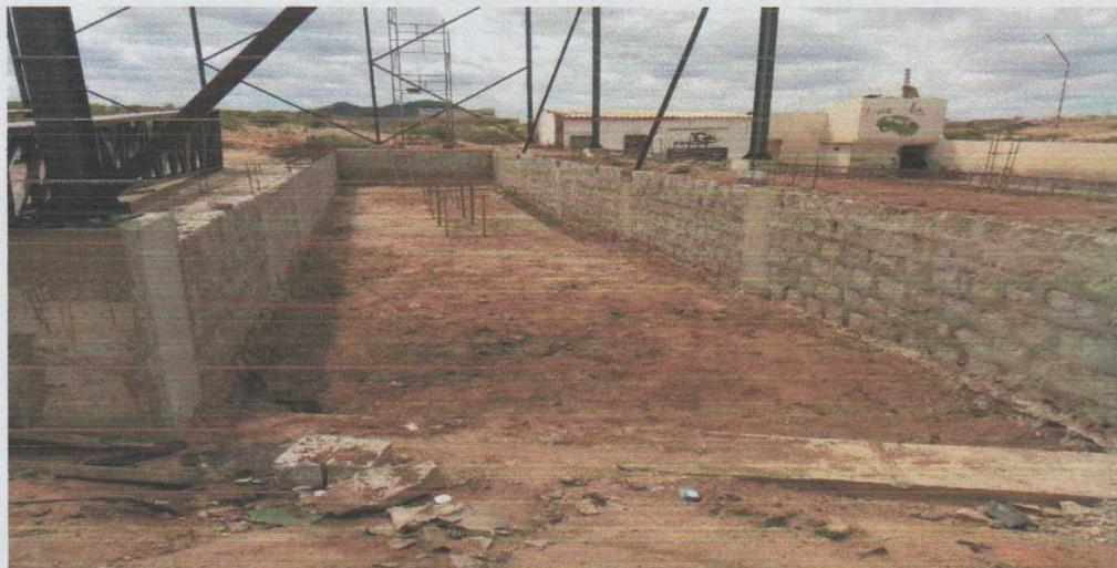
Figura 4: Estrutura de muro de contenção para entrada de veículos para carga e descarga na galpão. Fonte: O autor (2016)
