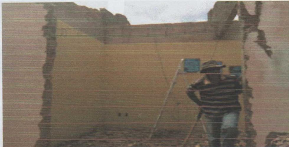
Figura 11: Observa-se a ferragem sem concreto, pois o mesmo estava completamente solto. Fonte: O autor (2016)
