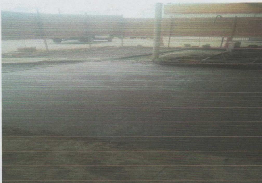
Figura 9:Parte do piso concretado aguardando a máquina acabadora. Fonte: O autor (2016)
