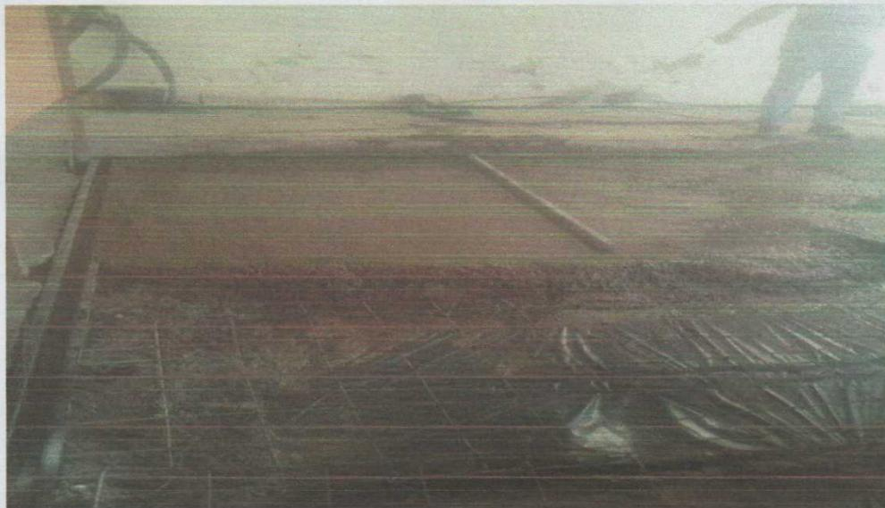
Figura 8:Fase de concretagem do piso. Fonte: O autor (2016)
