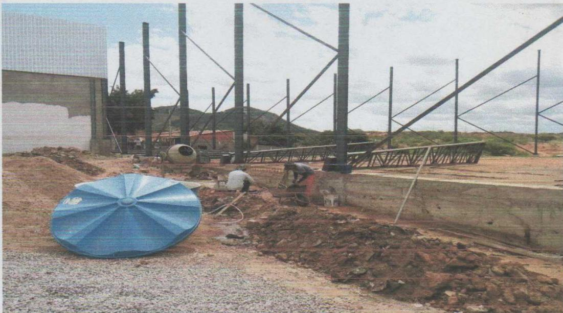
**Figura 6:Terreno Compactado, estrutura metálica vertical pronta, restando apenas a fase de concretagem.
