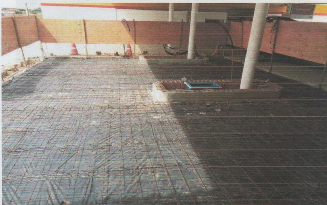
Figura 7: Estrutura já com a lona, a treliça e a tela de aço galvanizado 4.2, ilhas locadas, pronto para receber o concreto. Fonte: O autor (2016)
