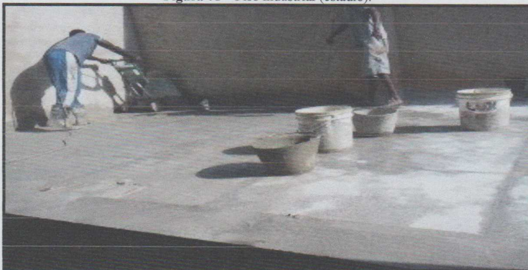
Figura 01 – Piso industrial (estádio).
