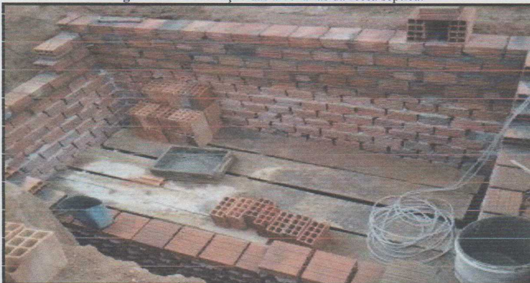
Figura 07 – Construção das alvenarias da fossa séptica.
