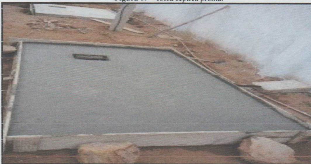
Figura 09 – fossa séptica pronta.
