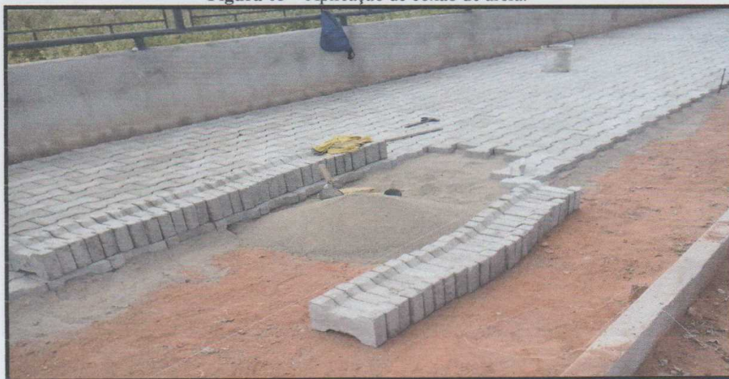
Figura 03 – Aplicação de coxão de areia.
