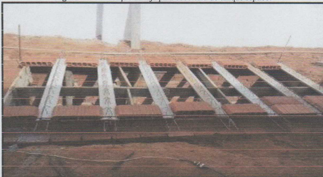
Figura 08 – Execução da laje para cobertura do tanque séptico.
