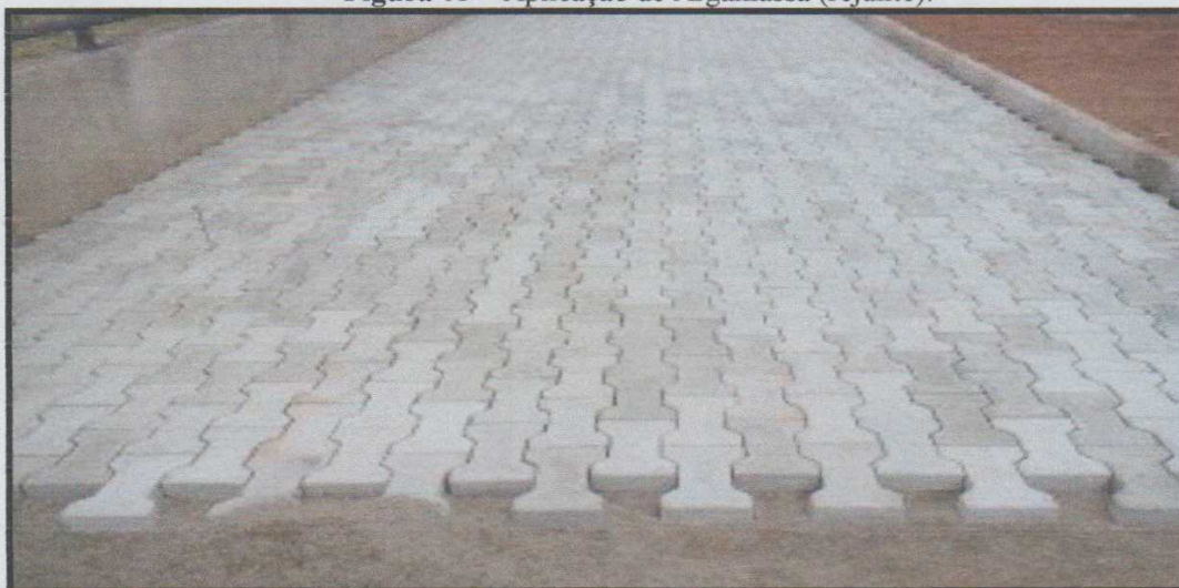
Figura 05 – Aplicação de Argamassa (rejunte).
