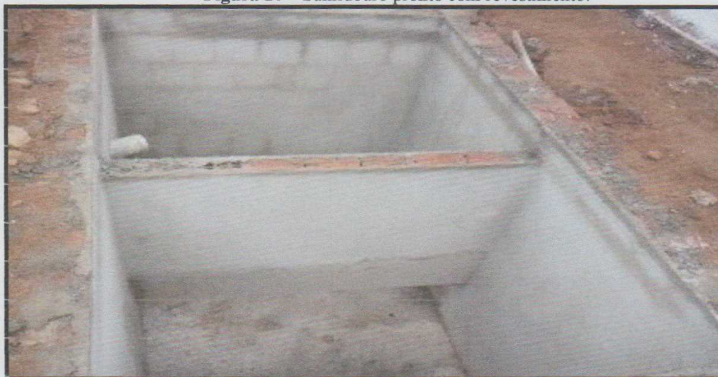
Figura 10 – Sumidouro pronto com revestimento.
