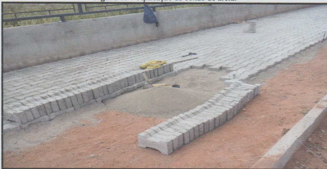
Figura 03 – Aplicação de coxão de areia.
