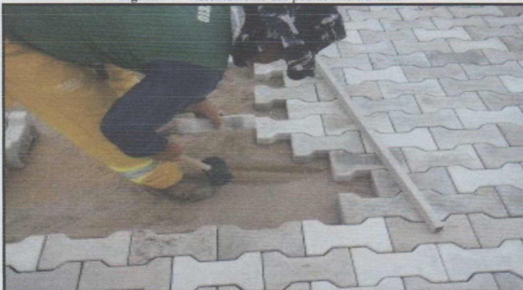
Figura 04 – Assentamento das pedras intertravadas.
