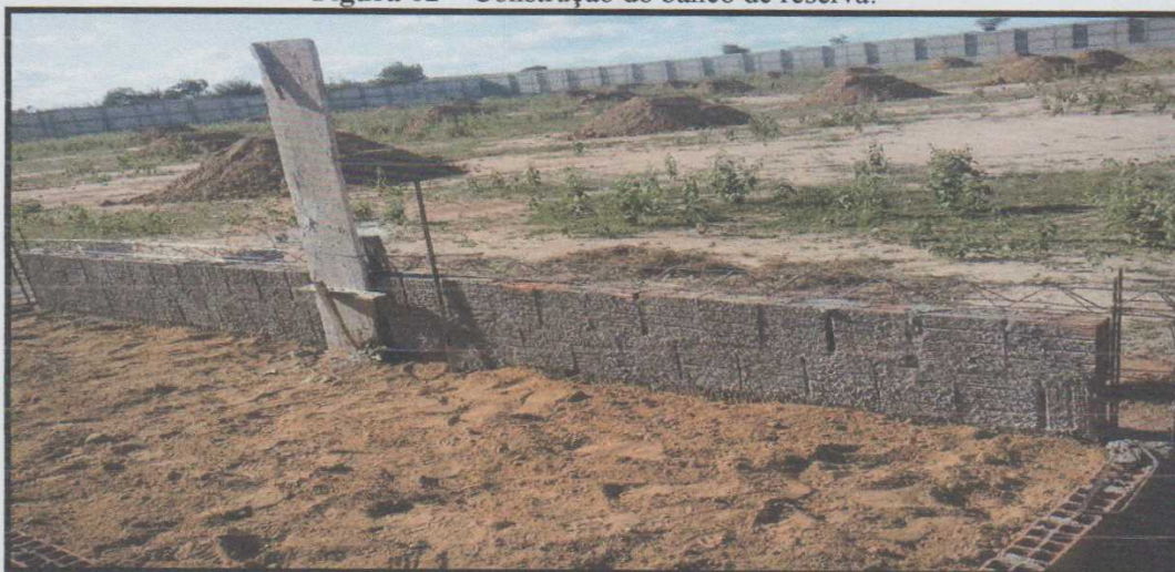
Figura 02 – Construção do banco de reserva.
