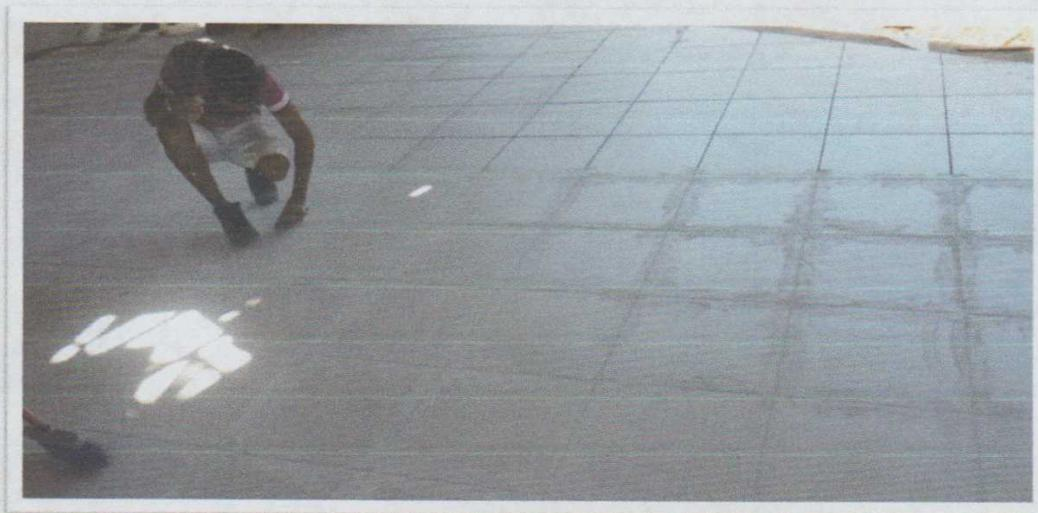
**Figura 22.** Assentamento de revestimento Cerâmico.
