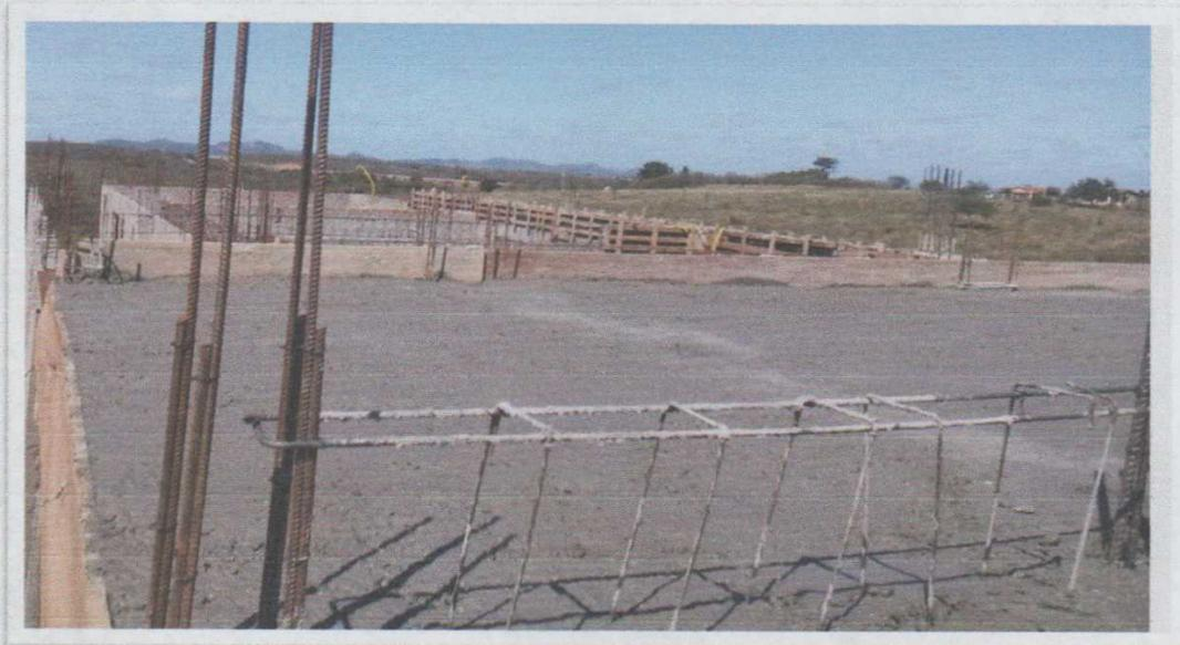
**Figura 16.** Concretagem de laje.
