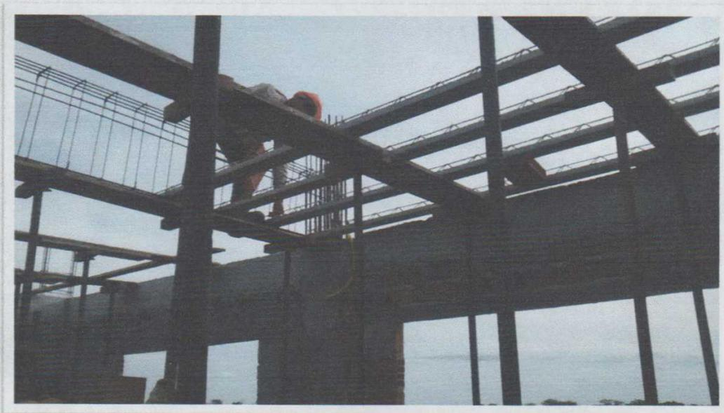
**Figura 14.** Colocando a ferragem na laje.
