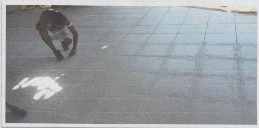
**Figura 22.** Assentamento de revestimento Cerâmico.
