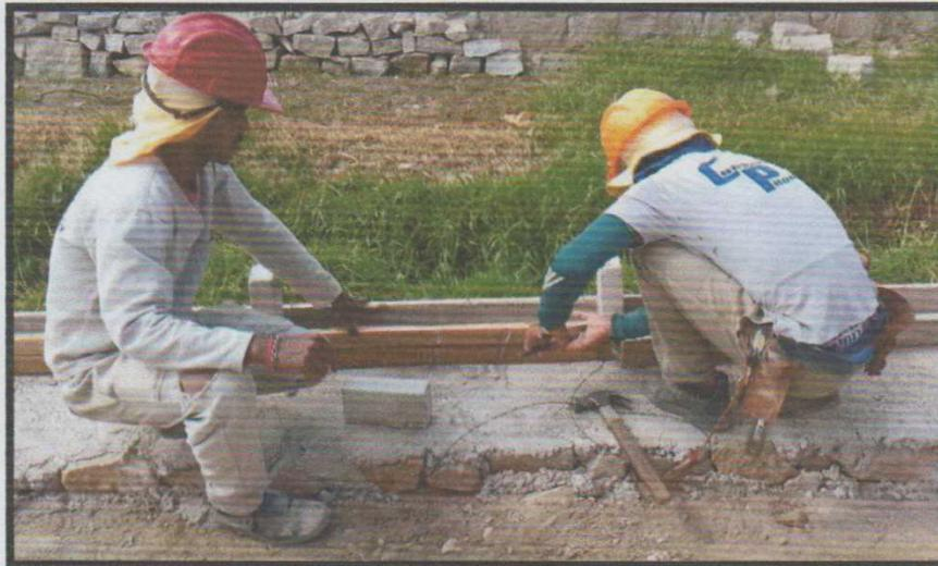
Figura 5: Instalação das fôrmas.
