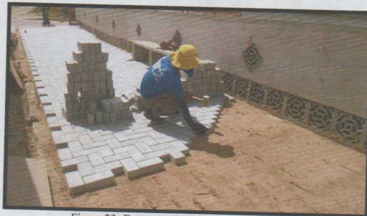
Figura 23: Execução do piso com blocos Pavers.
