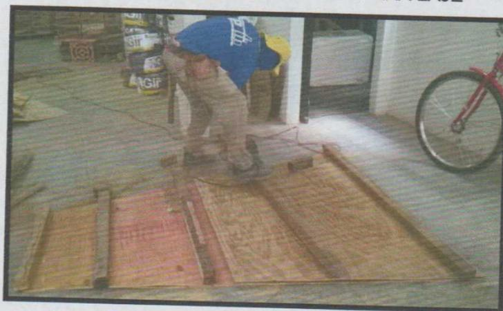
Figura 21: Fabricação de uma forma para laje da boca de lobo.
