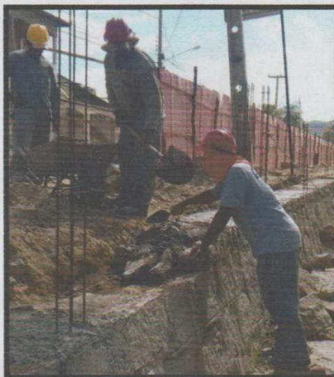
Figura 4: Execução da base em pedra argamassada.
