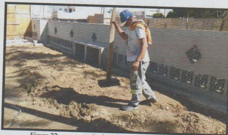
Figura 22: compactação do solo para assentamento do piso.
