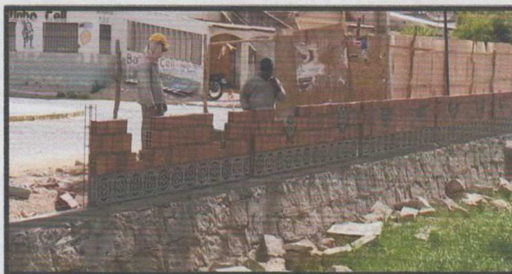
Figura 9: Alvenaria de blocos cerâmicos aparelhados.
