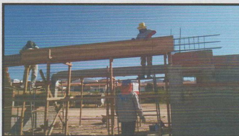
Figura 31: Montagem das fôrmas para a viga do salão.
