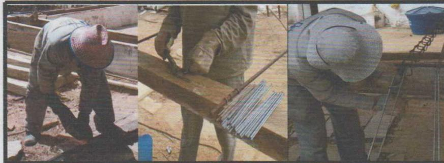
Figura 3. Corte, Dobra e Armação das armaduras, respectivamente.
