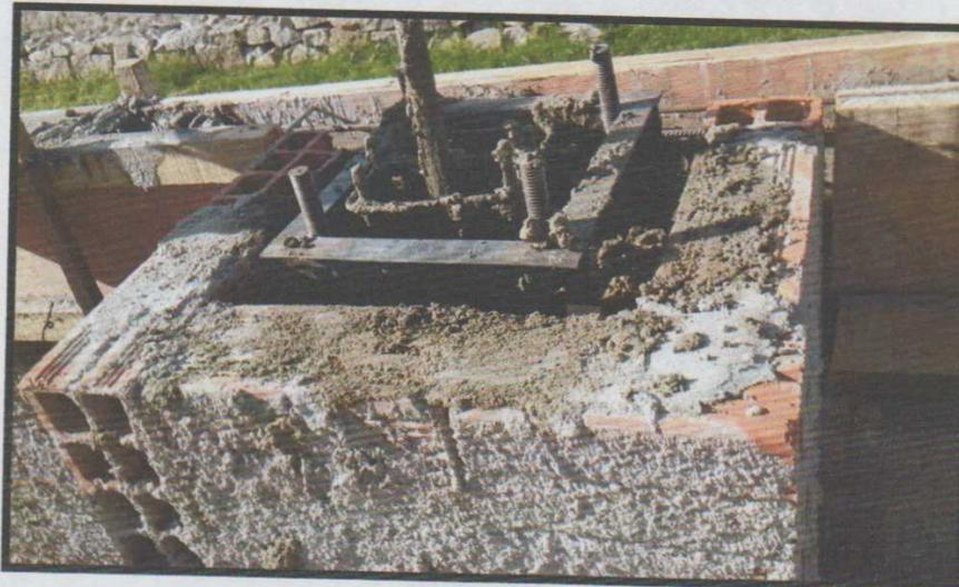
Figura 18: Estrutura de base para assentamento do poste com parafusos de espera.
