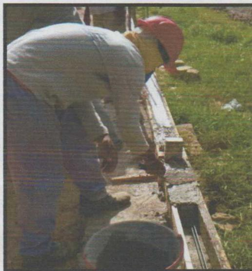
Figura 6: Disposição da ferragem e concretagem.
