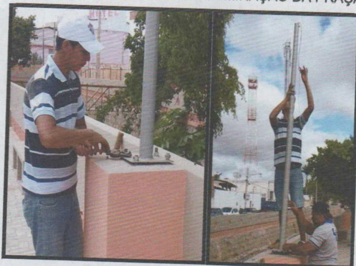
Figura 24: Fixação de um poste de iluminação.
