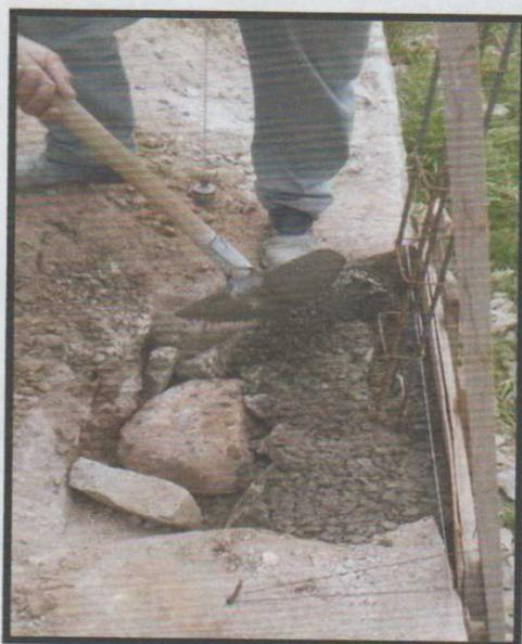
Figura 15: Concretagem da sapata.
