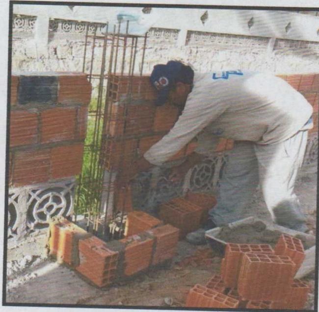
Figura 17: disposição de armadura e execução de forma em alvenaria para pilar.
