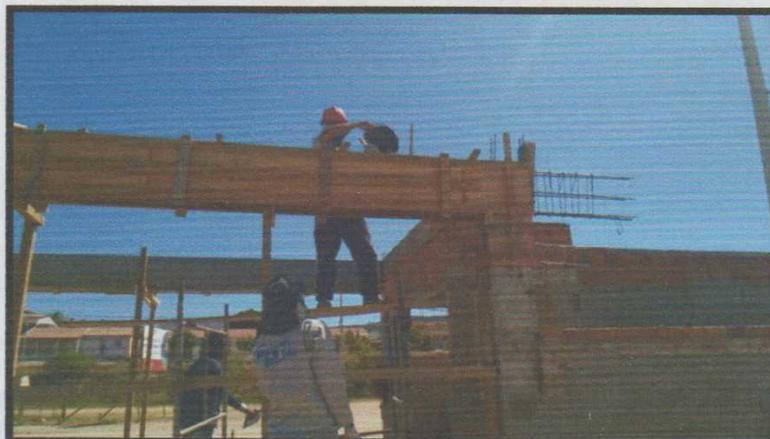
Figura 33: Concretagem de uma das vigas.
