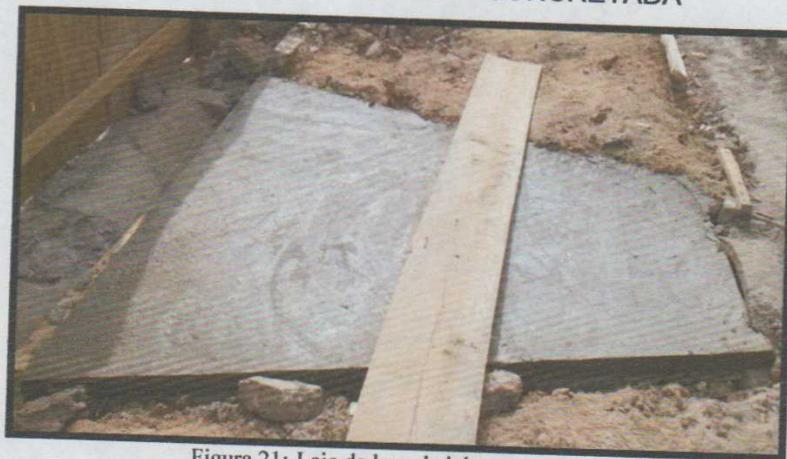
Figura 21: Laje da loca de lobo concretada.
