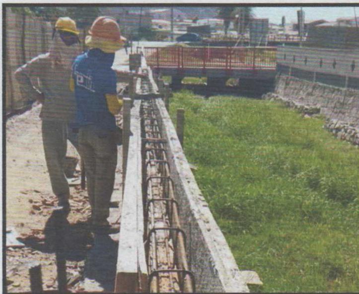
Figura 10: Processo de execução da viga superior da alvenaria lateral.
