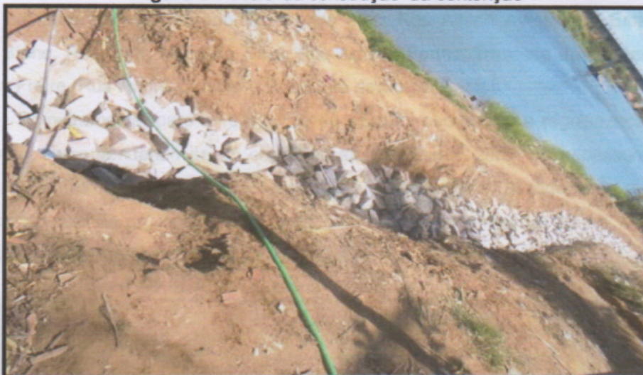
Figura 2 – Início da construção da contenção
