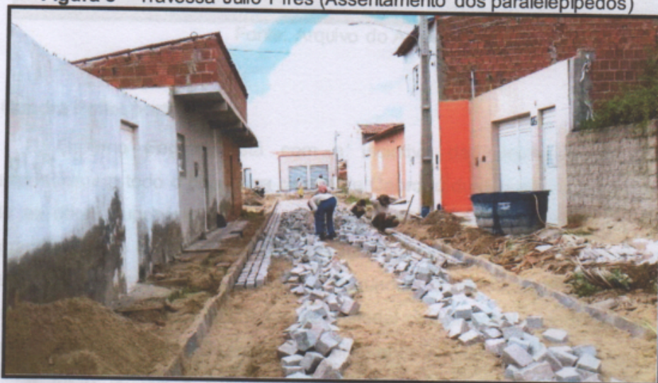
Figura 5 – Travessa Júlio Pires (Assentamento dos paralelepípedos)
