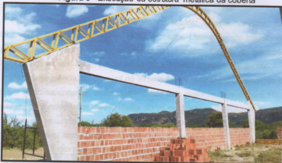
Figura 8 - Execução da estrutura metálica da cobertura
