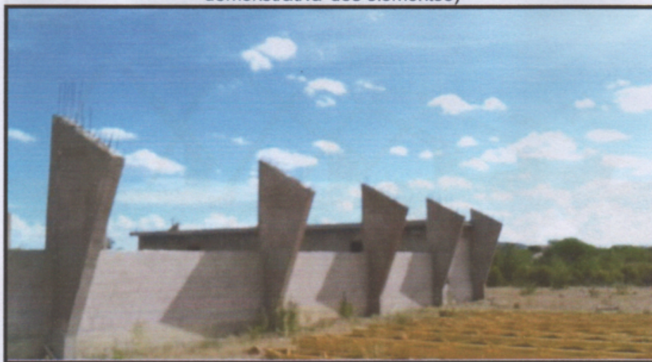
Figura 7 - (Preparação do início da montagem da cobertura e foto demonstrativa dos elementos)
