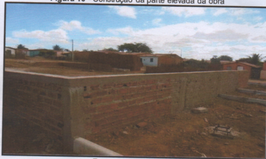
Figura 10 - Construção da parte elevada da obra
