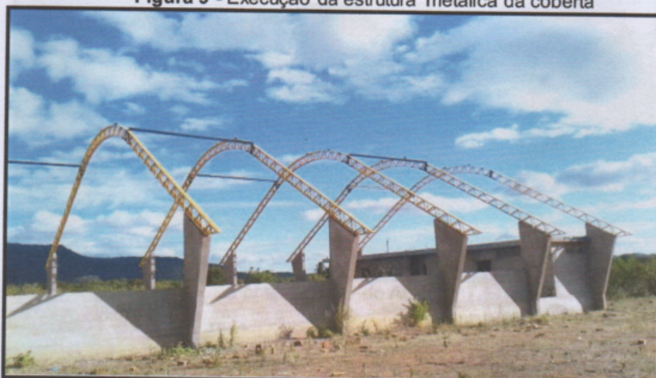
Figura 9 - Execução da estrutura metálica da cobertura
