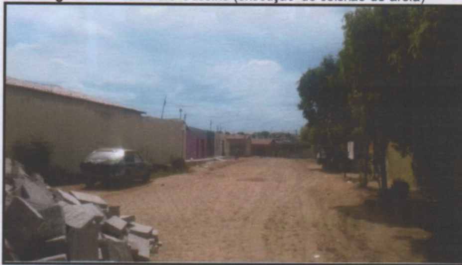
Figura 4 – Rua André Cussino (execução do colchão de areia)
