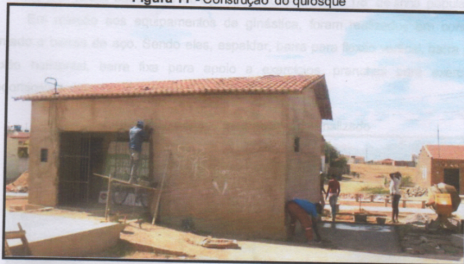
Figura 11 - Construção do quiosque
