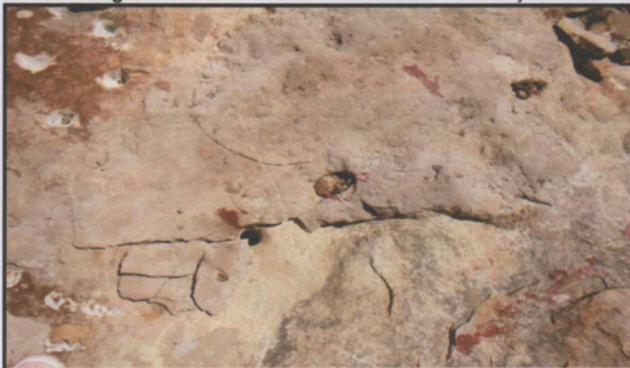
Figura 1 - Afloramento de rocha na cota da fundação
