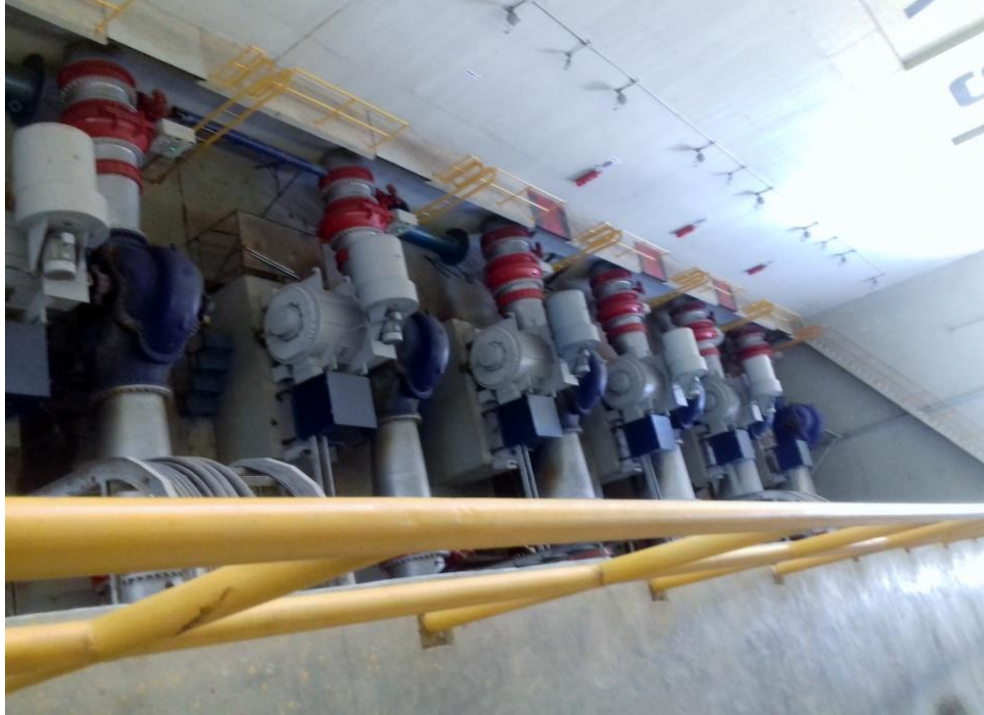
Figura 2A. Sistema informatizado de controle das comportas do canal principal do PISNC.
