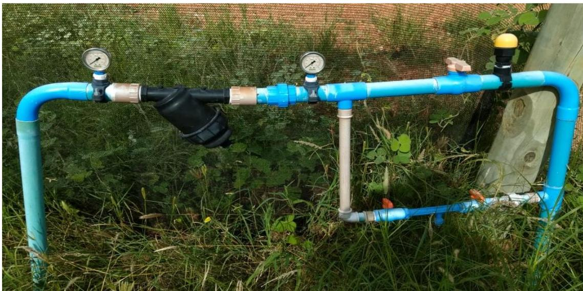
**Figura 4:** Filtro de disco e manômetro (B) - Petrolina (PE), 2020.
